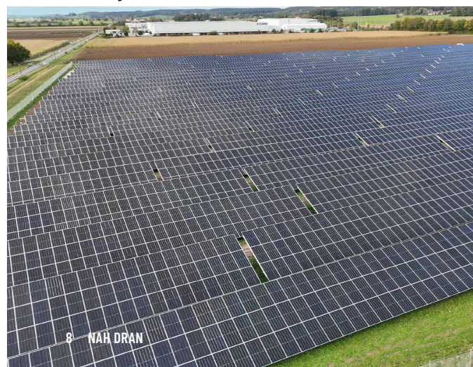
PV-Freiflächenanlage im Mindelheimer Gleisdreieck.
